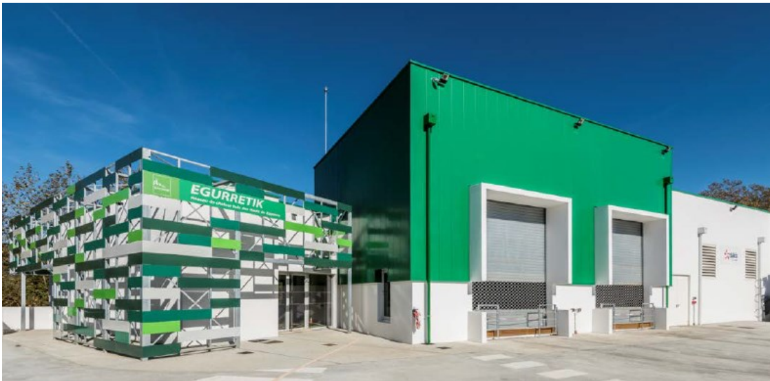
Vue de la chaufferie centrale (source : rapport annuel)
